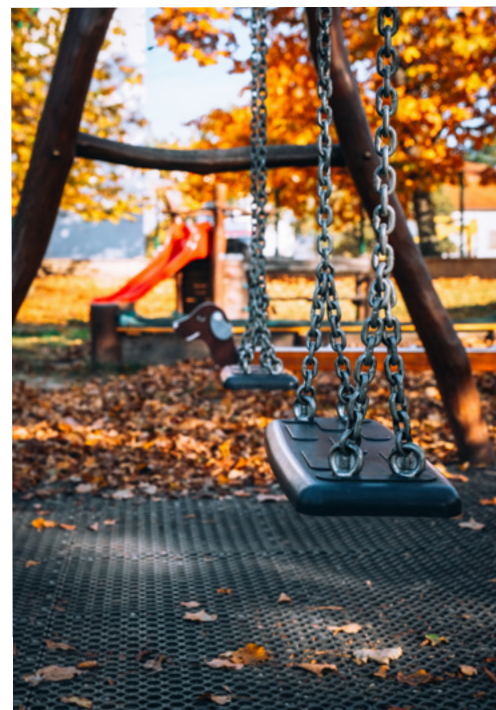
Nová dopadová plocha pod houpačkami
